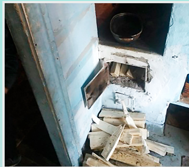
Запрещено размещать и хранить на предтопочном листе любые сгораемые материалы
